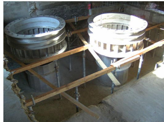
Abb. 06: Klappenlaufradturbine (Quelle: Franz Schandl Brandschutz- und Industrietechnik)
